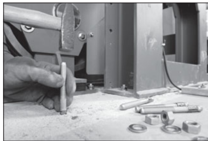
Рис. 1. Распорный анкер для крепления стальной конструкции
