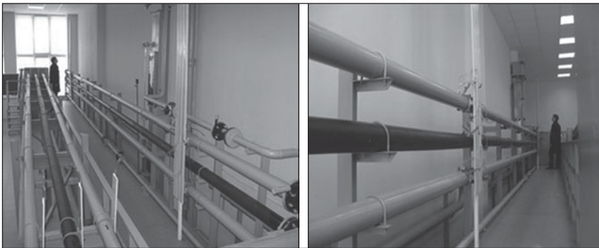
Рис. 3. Общий вид гидравлического стенда с обеих сторон
