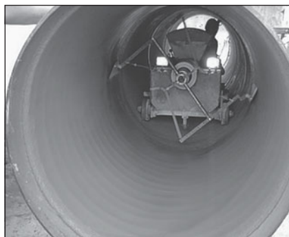
Рис. 1. Нанесение цементно-песчаного покрытия
