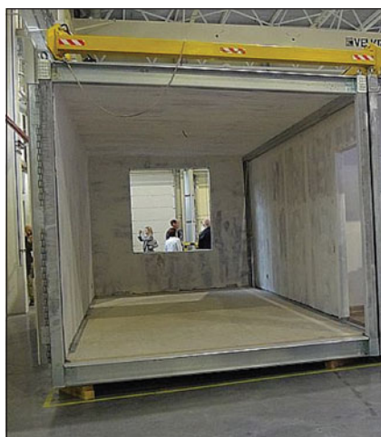
Рис. 1. Одноэтажные модули после сборки на заводе
