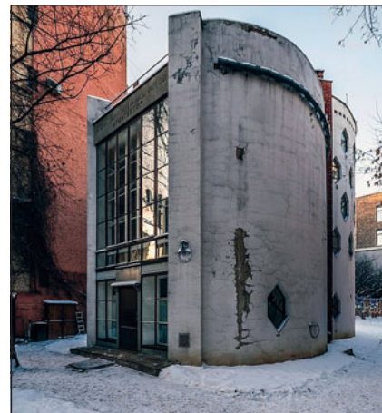
Рис. 1. Вид здания со стороны переулка (2016 г., [3])
