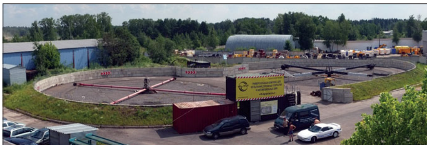
Рис. 2. Универсальный комплекс для испытания дорожных покрытий и автомобильных шин
