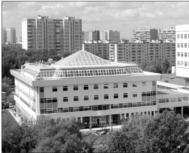
Новое здание факультета ПГС в составе ИСА на Ярославском шоссе
